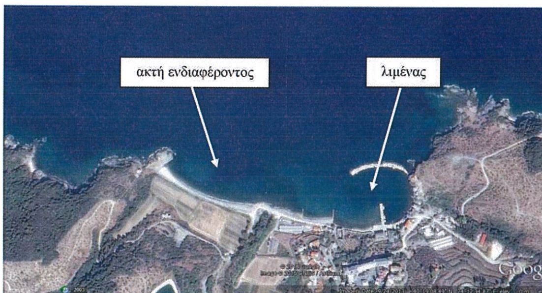
Σχήμα 1. Η παράκτια ζώνη του Όρμου Βατοπαιδίου πριν την αναβάθμιση του λιμένα.
