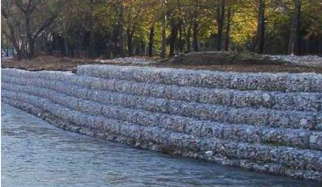
Φωτ.: 1.1: Τυπική διάταξη συρματοκιβωτίων σε ποταμό / ρέμα.
